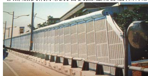
圖三.頂部加裝消音圓筒之隔音牆(南亞)
