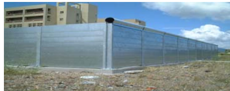
圖十五. 安裝隔音牆後之試驗場測視圖
