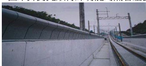
圖一.頂部加裝消除繞射音裝置之隔音牆(日東紡)
