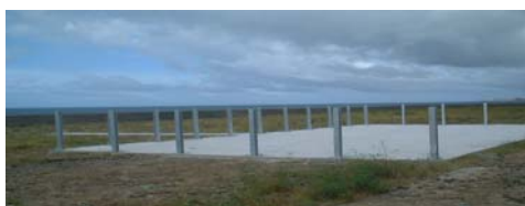
圖十四. 安裝隔音牆前之試驗場測視圖
