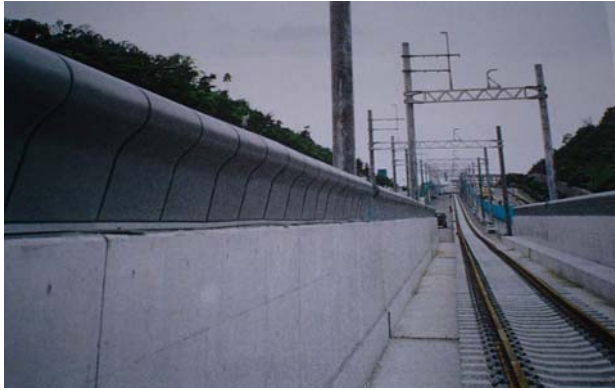
圖 4.(a)蘑菇形頂邊消音裝置[2]
