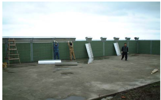
圖 22(a) 防音牆頂緣消音裝置安裝圖
