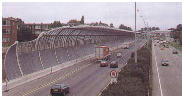
圖 2.弧形造型的防音牆[1]
