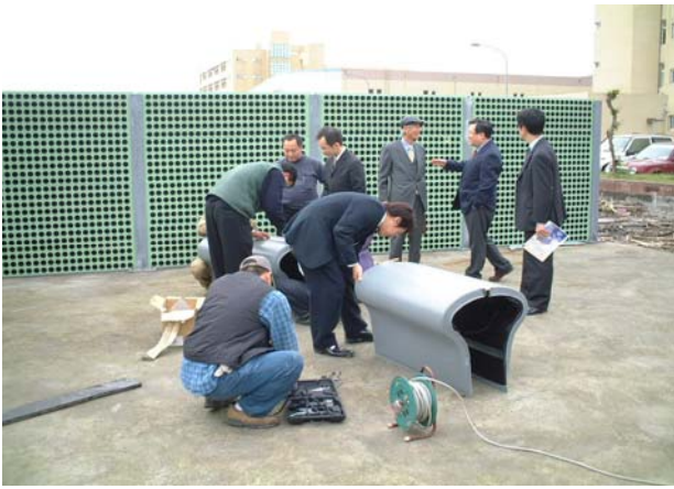
圖 22(b) 防音牆頂緣消音裝置安裝圖
