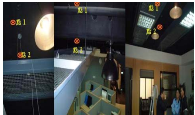
圖 15 一樓辦公室吊掛燈具振動量測
