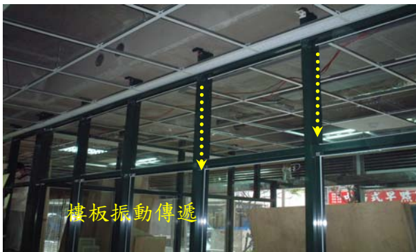
圖 5. 分間牆骨架振動傳遞
