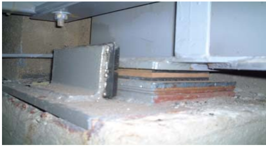
圖 21、原驅動馬達平台橡膠墊圖
