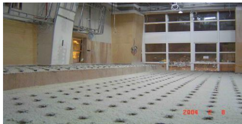
圖 14 SC 大跨距面積浮動地板施作及完成圖
