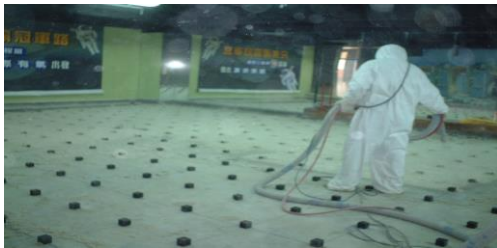
圖 13 RC 小面積樓板浮動地板施作及完工使用圖
